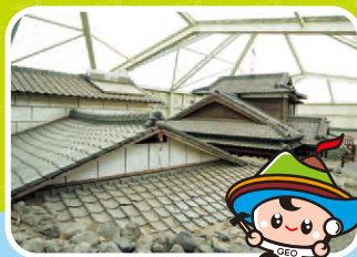
土石流被災家屋保存公園
